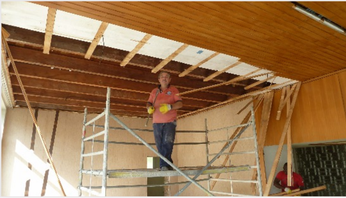
Abbruch der Deckenverkleidung mit Stemmeisen
